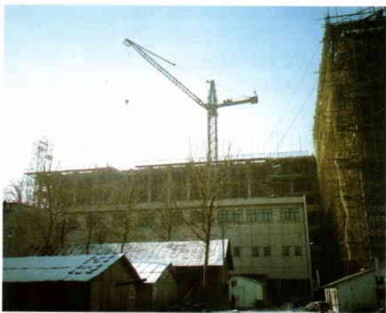
▲増築中の中国海洋データセンター（天津市）
