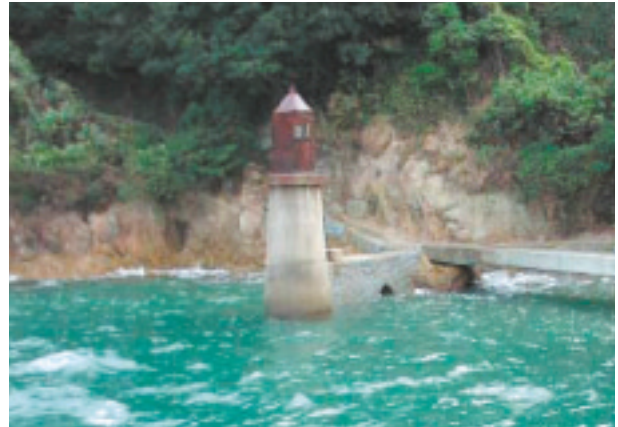
中渡島検潮器波除塔
