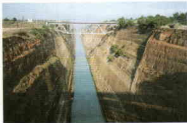
コリント運河をバス道路から見る。右が本土、左が半島
