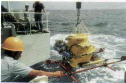
海洋観測機器の設置風景
