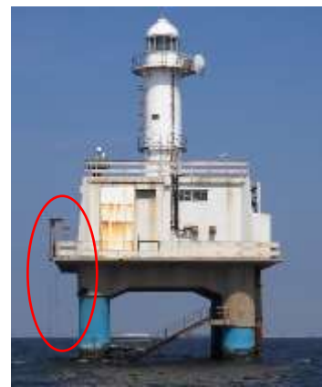
千葉灯標に設置したモニタリングポスト (図中赤線内)
