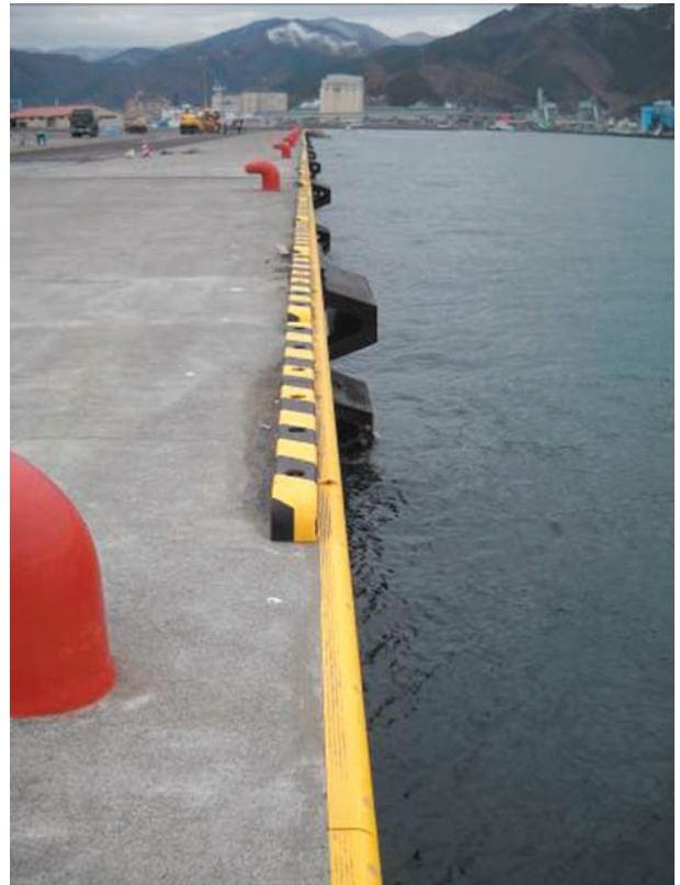
写真 3 d 岸壁. Photo 3 d Quay.
