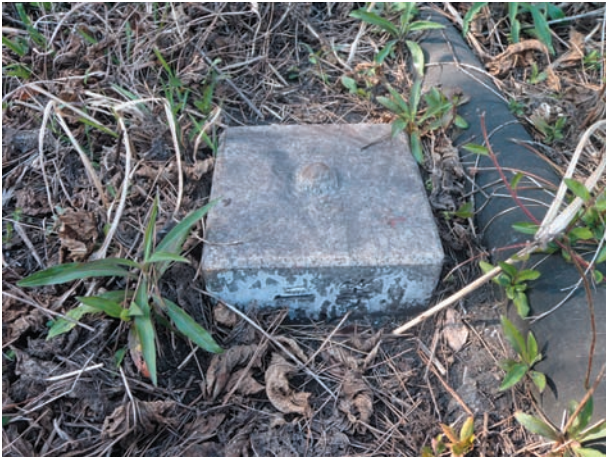
写真 16 c 基本水準標. Photo 16 c Bench mark.
