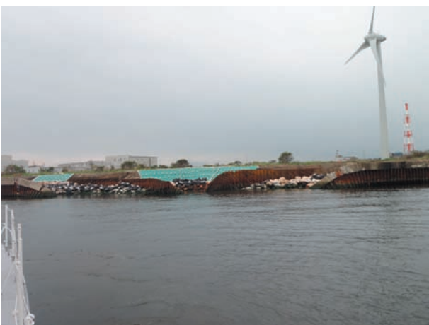
写真 16 k 石油護岸。 Photo 16 k Oil seawall.
