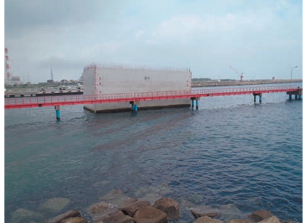
写真 17 c 浅瀬に打ち上げられたケーソン。 Photo 17 c Caisson on shoal.
