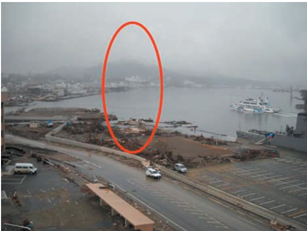
写真 8 b 流失した鉄塔. Photo 8 b Missing pylon.
