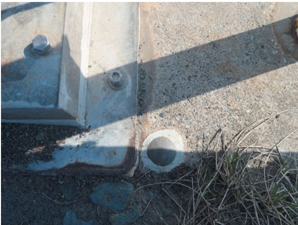
写真 12 c 基本水準標. Photo 12 c Bench mark.
