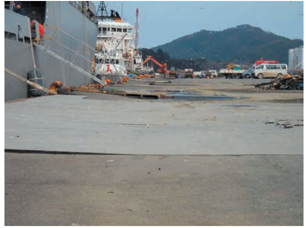
写真 5 g 気仙沼港朝日ふ頭。 Photo 5 g Asahi wharf in Kesen-numa Harbor.
