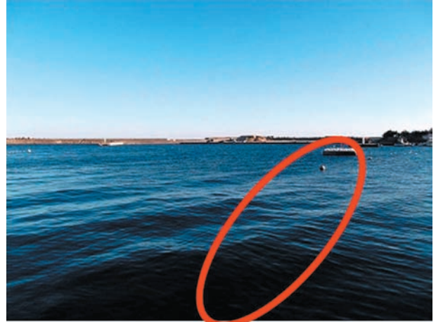
写真 21 e 崩れた防波堤 (平潟港). Photo 21 e Destroyed breakwater (Hirakata Harbor).
