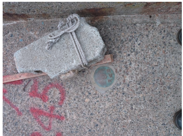
写真 14 c 基本水準標。 Photo 14 c Bench mark.
