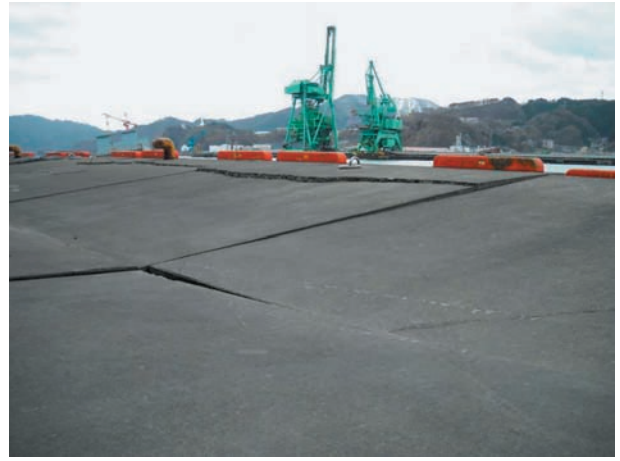
写真 2 f 傾いたふ頭。 Photo 2 f Tilted wharf.
