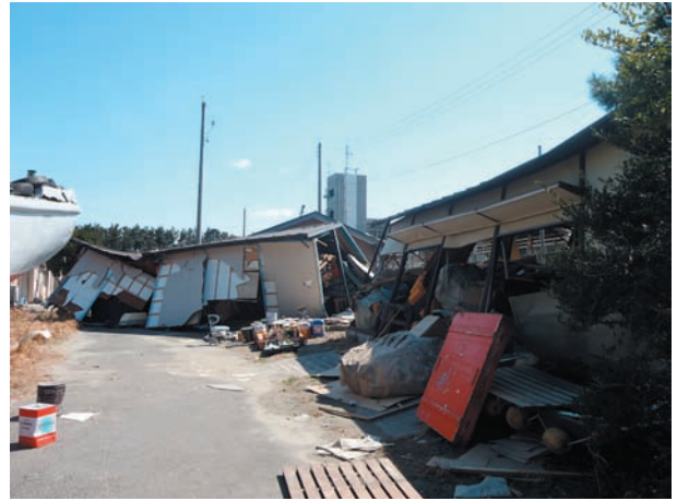
写真 16 f 崩れた保管庫. Photo 16 f Destroyed storage.
