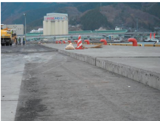
写真 3 b 平滑化工事中. Photo 3 b Smoothing a wharf.
