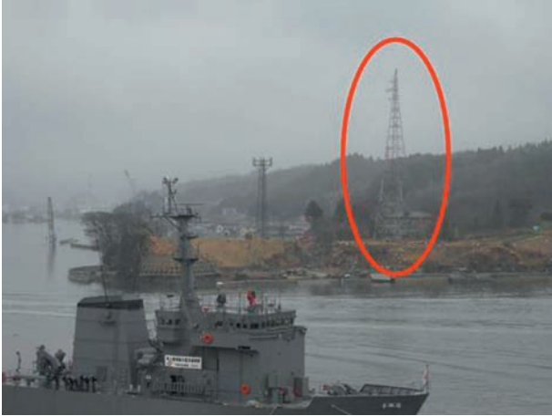
写真 8 a 鉄塔. Photo 8 a Pylon.
