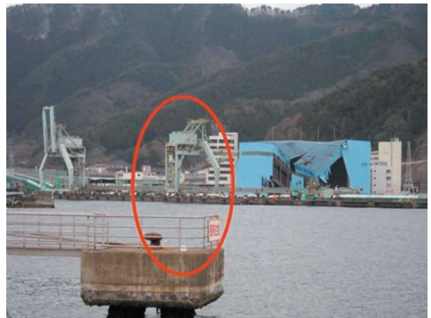
写真 3 i 流失した灯。 Photo 3 i Missing light.
