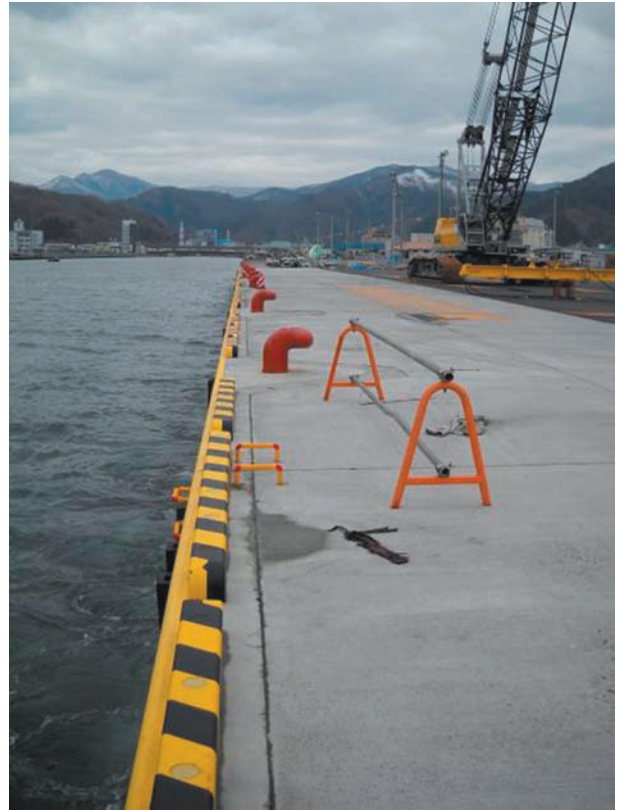
写真 3 c 岸壁. Photo 3 c Quay.
